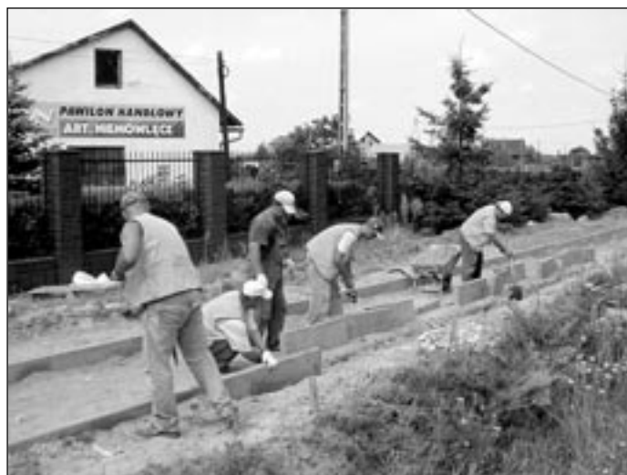
Budowa chodnika w Olszynach.
