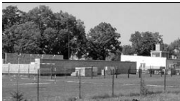
Budowa sali w Jadachach.
