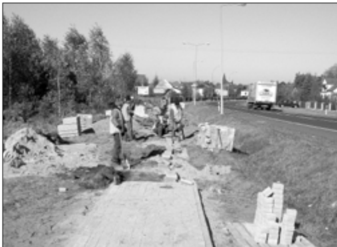
Budowa chodnika na Bieszczadzkiej.
