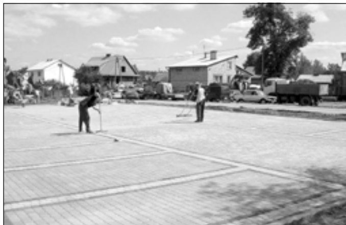
Budowa parkingu przy SP 3.
