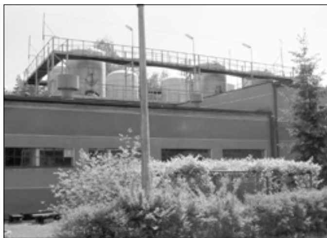
Zakład Produkcji Wody.
