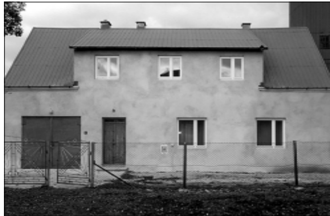
Nowe tynki na remizie w Alfredówce.
