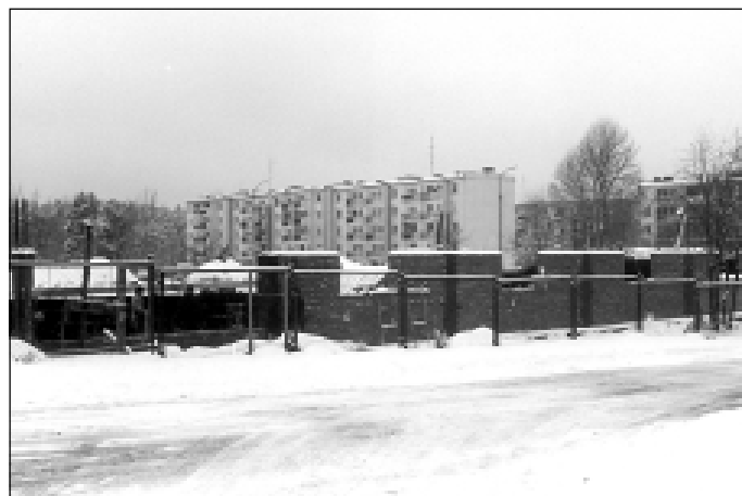
Trwają prace przy budowie hali.
