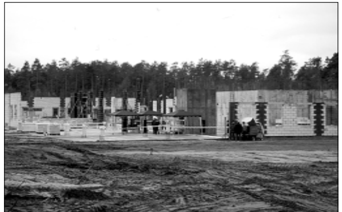
Obiekt w trakcie budowy.
