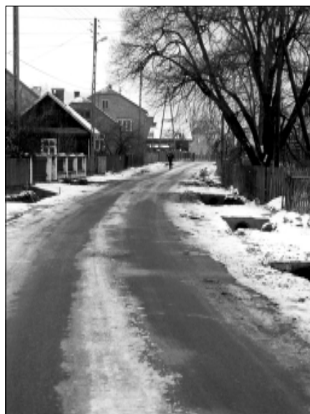
...i po modernizacji.
