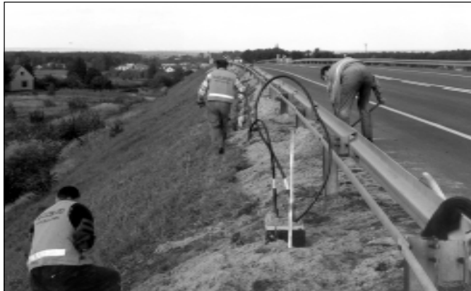
Prace przy budowie oświetlenia na wiadukcie.
