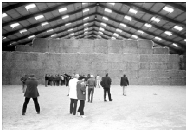
Magazyn paliwa w zwiedzanej kotłowni na słomę.
